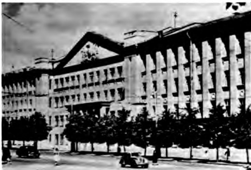
Новый учебный корпус БГИНХ им. В.В. Куйбышева на ул. Свердлова, 7, введенный в эксплуатацию с 1950 по 1954 г. В настоящее время здесь размещается один из факультетов вуза. Фото 1960-х гг.
