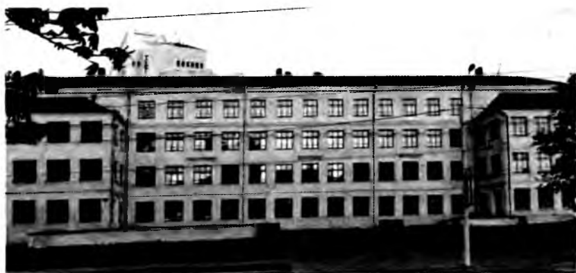
Здание средней школы на ул. Мясникова (ныне это дом № 5), в котором размещался БГИНХ им. В.В. Куйбышева в послевоенный период (1945–1950). Строение сохранилось до наших дней, в настоящее время не эксплуатируется. Фото 2023 г.
